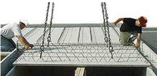
BILD 1 Transport von Elementdeckenplatten
