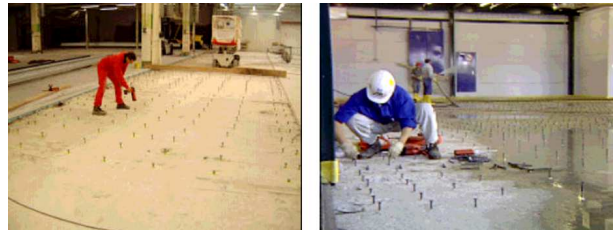
BILD 6 Verstärken einer Decke mit Dübeln
