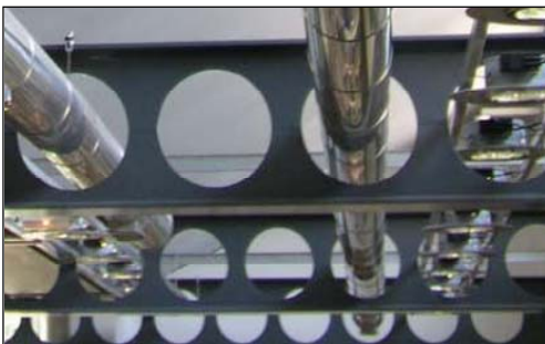
BILD 1: Steglochträger aus dem Stahlbau
