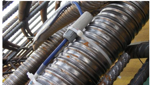
Bild 4: Mörtelummantelte Einzeldrahtsensoren auf dem Loopingspannglied eines Faulturmes, /3/
