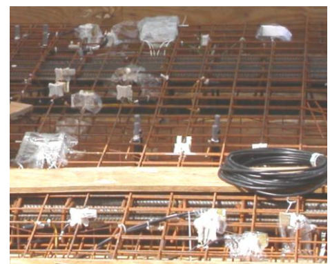
Bild 3: Einbau der Korrosionssensoren in die Platte
