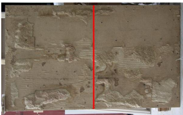
Bild 4 Zustand der Spanplatte hinter der Lehmplatte nach 60-minütiger ETK-Beflammung /1, iBMB/
