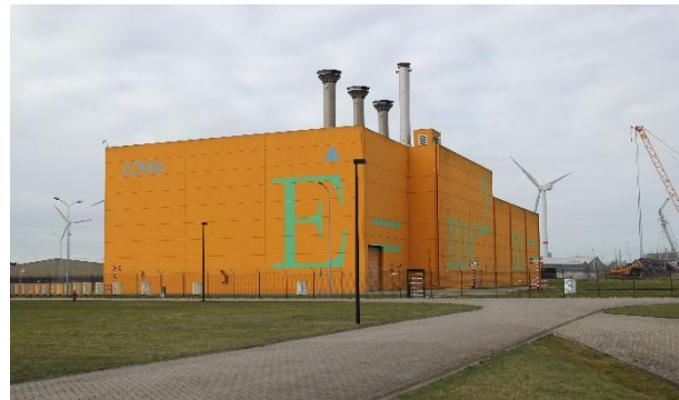
Bild 1: Niederländische Anlage HABOG zur längerfristigen Zwischenlagerung von hochradioaktiven Abfällen in Vlissingen
