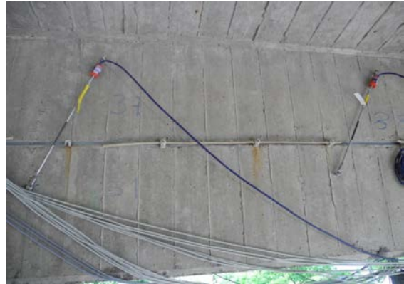
Bild 2: Ausgeführte primäre Sensorik als Kompensationsmaßnahme für das Querkraftdefizit an der Steginnenseite
