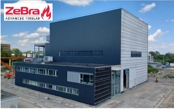
Bild 2 ZeBra kurz vor der Fertigstellung
