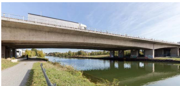
Bild 1: Plattenbalkenbrücke in Wolfsburg mit gevouteten Betonbauteilen (Autobahn A39)
